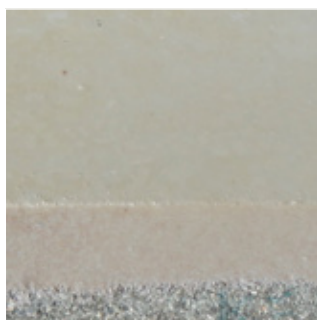
Verfärbung ohne Bitumen Primer
